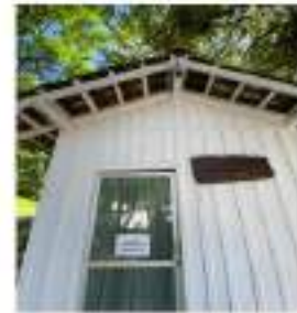
SALA DE ATENDIMENTO PSICOLOGIA
